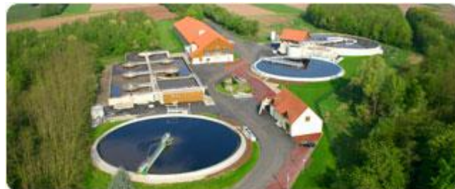
Station d'épuration « Brunnwasser » à Sélestat
