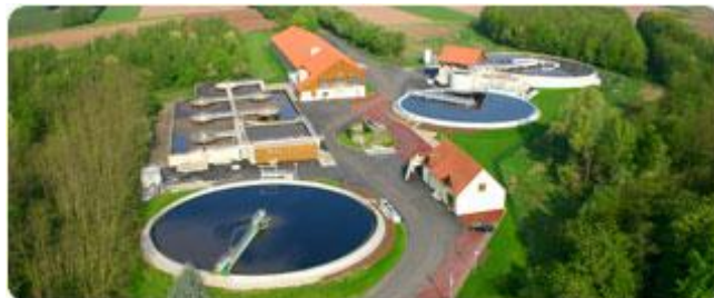
Station d'épuration « Brunnwasser » à Sélestat
